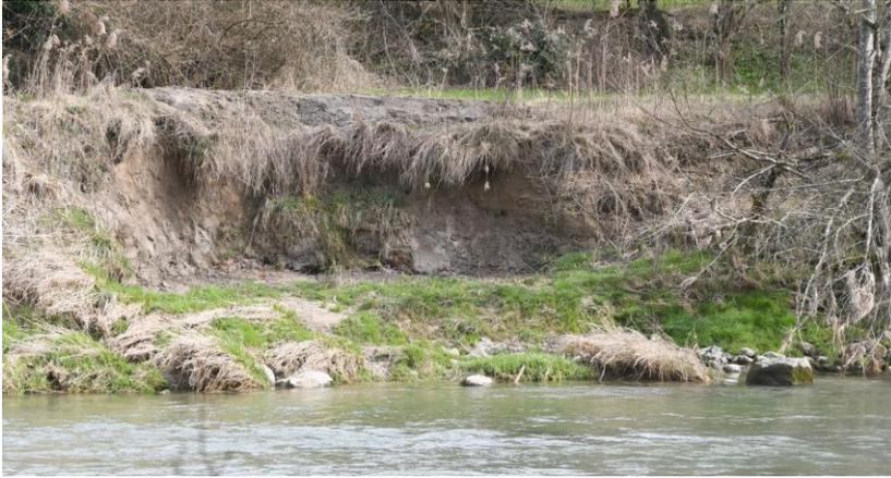
*Abb. 12: Unterhalb der Ossinger Eisenbahnbrücke (Chlini Au) wurde die Steilwand mit dem Bagger wieder instand gestellt. Das abgegrabene Erdmaterial wurde dabei auf der Böschungsoberkante deponiert.*
