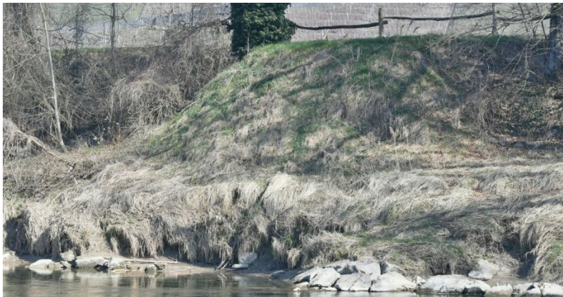
Abb. 9: Die im 2024 errichtete Sandschüttung (oben) wurde im März 2025 mit dem Bagger partiell senkrecht abgegraben.
