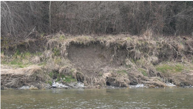
Abb. 7: In den Widen wurde die Böschung an der höchsten Stelle senkrecht abgegraben.
